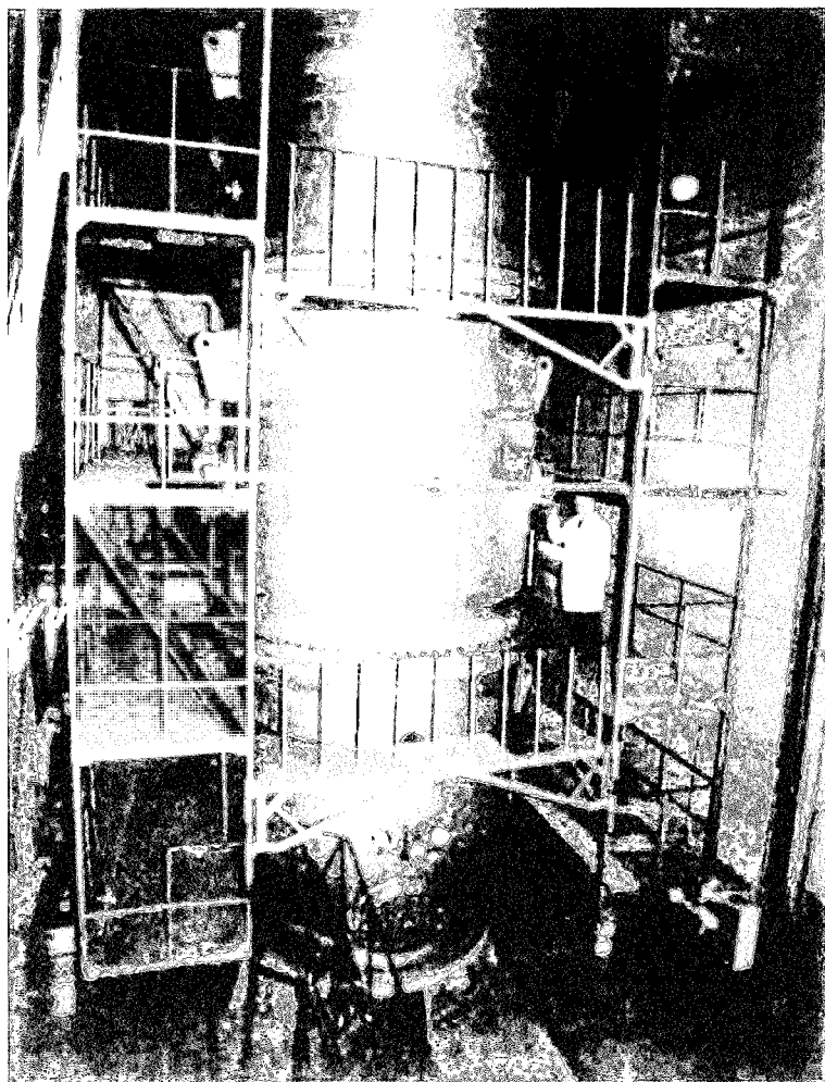
Электростатический перезарядный генератор ЭГП-10
