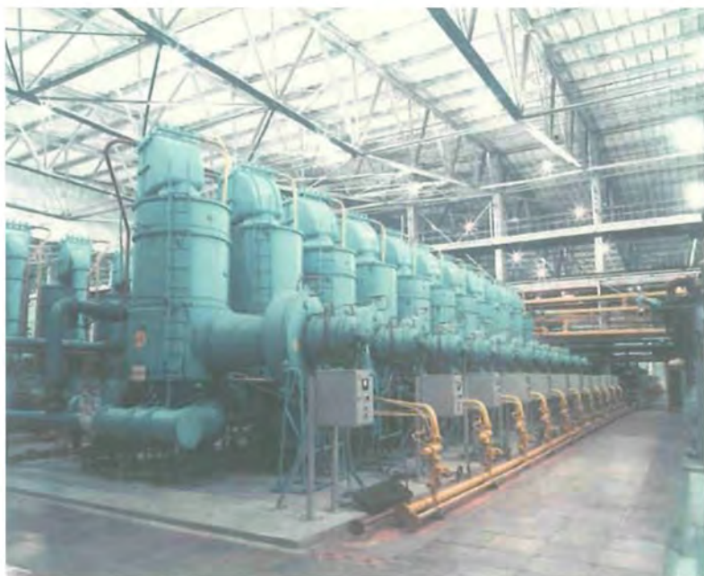
Блок газодиффузионных машин для производства обогащенного урана (Уральский электрохимический комбинат)
